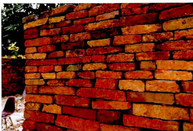
Hình 31. Gạch vồ được sử dụng chủ yếu trong xây dựng di tích
